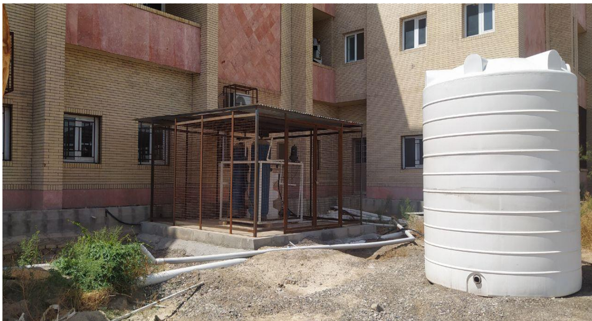
۱۲- نصب و راه اندازی پکیج آب خاکستری خوابگاه شهید خزایی
