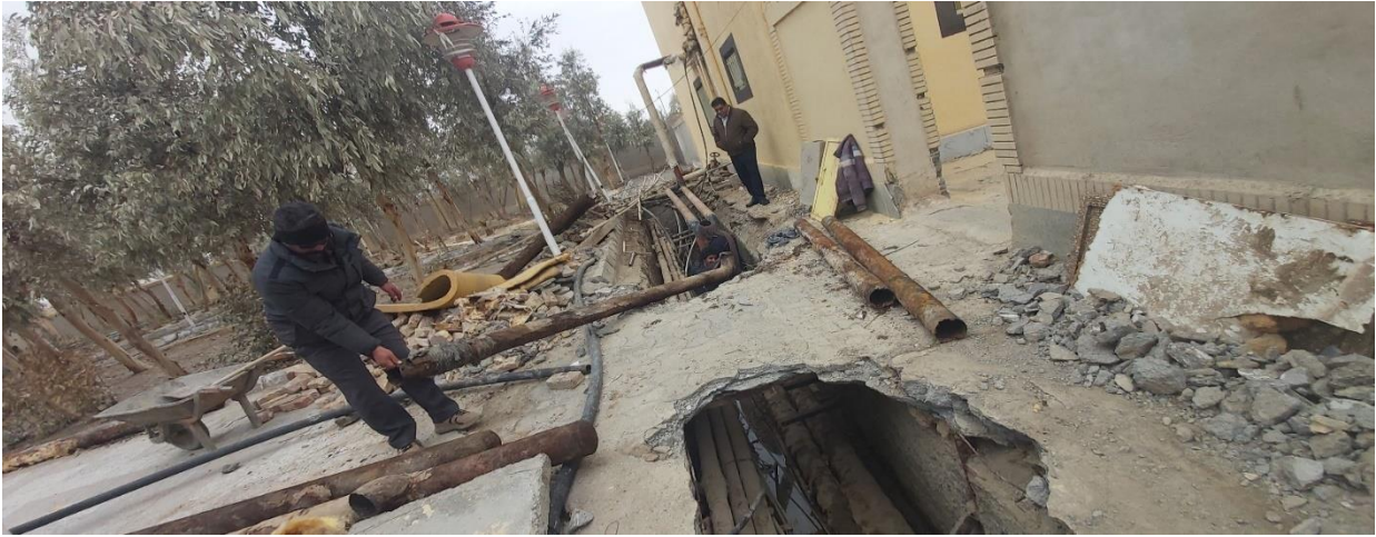
۱۹- فاز ۱ نوسازی خطوط لوله تاسیسات خوابگاه برادان سایت جدید
